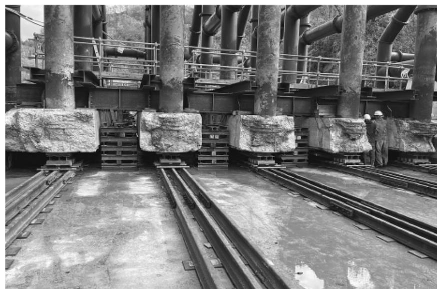
曳家状況(上流側)
