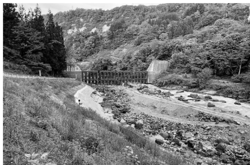
上流側から見た全景
