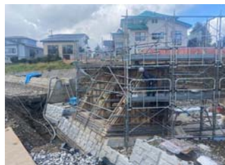
【流出口工・生コン打設】
