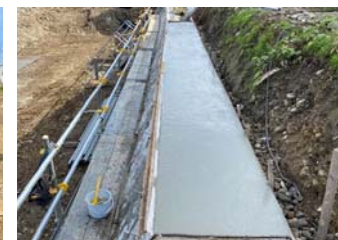
【天端コンクリート打設】
