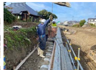
【天端コンクリート打設】
