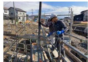
【流出口工・生コン打設】
