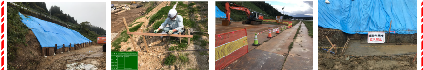
①法面養生・簡易土留め・簡易動態観測
